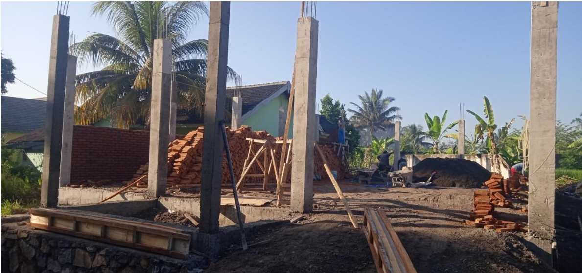
Gb. Pemasangan Bata Merah dan Kusen Jendela dan Pintu.
